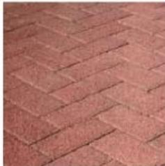
Les pavés en béton classiques à joint élargi mais pas encore jointoyé
