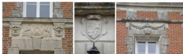
Les décors et renforts en pierre de la façade sur la cour d'honneur ainsi que le perron.
